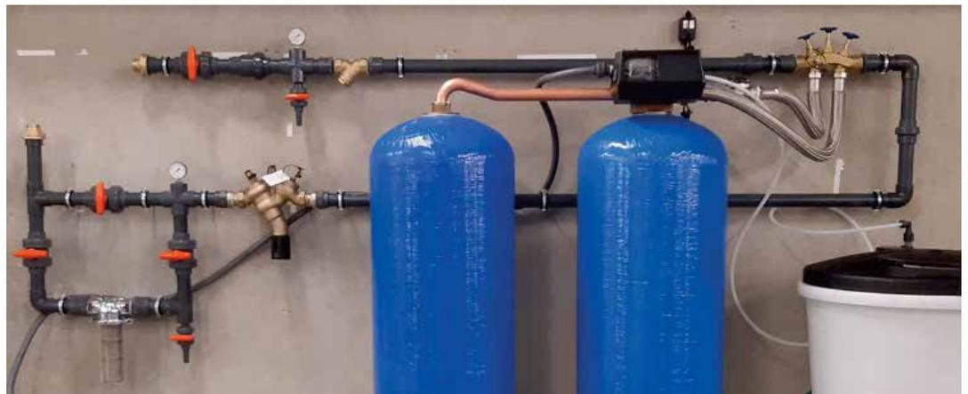
Beispiel einer Installation mit komplettem Anschluss der Kläranlage in PVC-U. So werden auch Installationen mit Anschlussmaßen von 2" und 3" sowie bei Bedarf auch kleinere Abmessungen realisiert.
