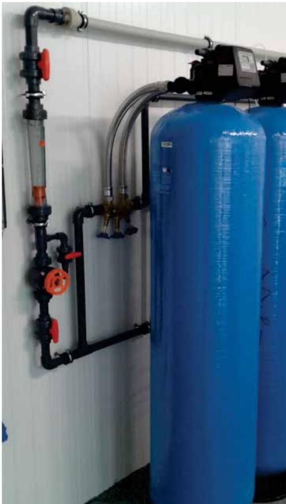
Ab der Rohrleitungsdimension 2" werden keine Montageblöcke und Verbindungsschläuche mehr benötigt. Alles wird mit PVC-U Fittings und Fittings umgesetzt
