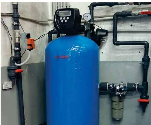
Klassischer Sandfilteranschluss mittels Halterung, am Rohr montiertem Anschlussblock und Verwendung von Edelstahl-Panzeranschlusschläuchen
