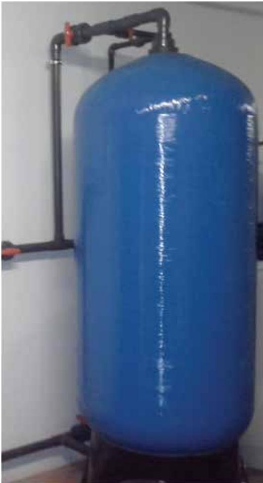
Anschluss des ECL - Entchlorungsfilters mit Clack-Regelventil zur automatischen Spülung. Ausführung des PVC-U-Rohranschlusses, PN16
